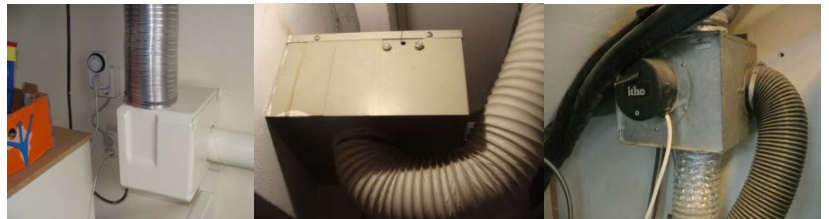
Een aantal voorbeelden van oude energie onzuinige ventilatieboxen
